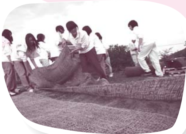
(鹿の食害・踏圧防止のための麻製シートの設置【若草山】)
