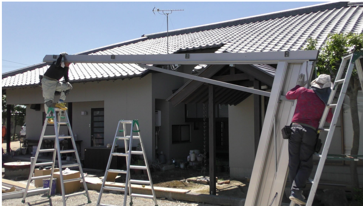
カーポートなら簡易的な足場で作業できる
