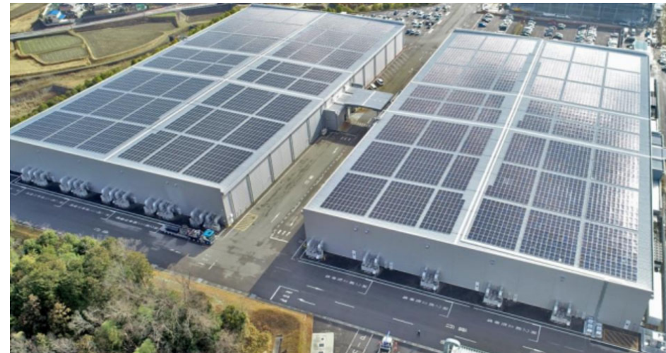
すでに屋根上に導入している例
