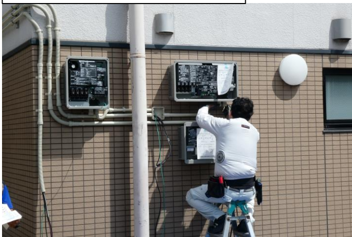
太陽光発電設備工事
