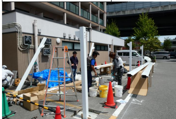
カーポート施工①
