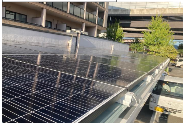
太陽光パネル設置
